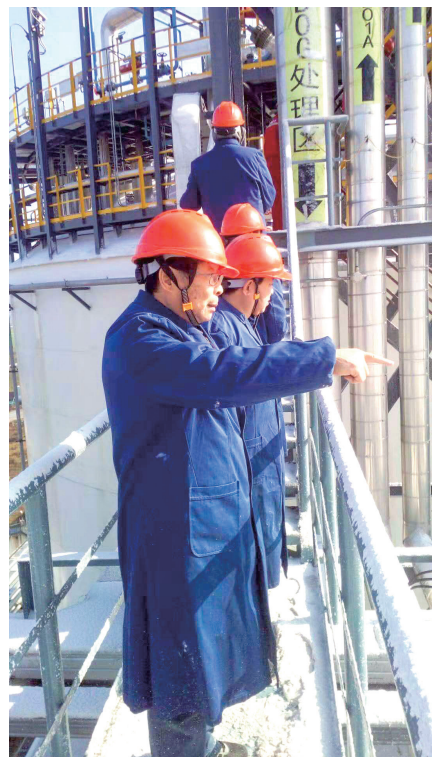
现场勘查险情
