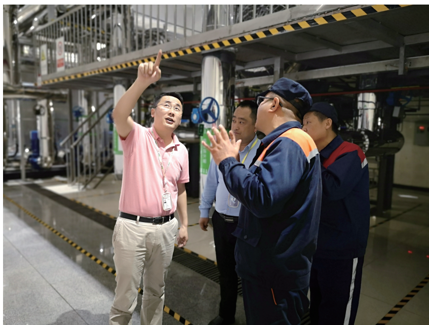
该公司厂领导对水处理间进行安全检查
