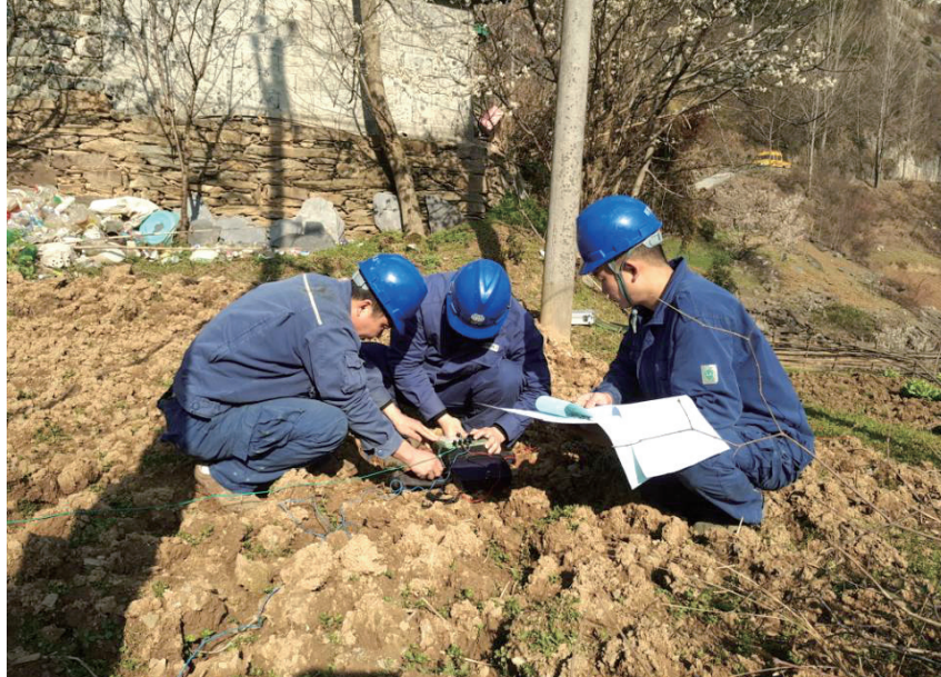
该公司城关运维班开展接地电阻测量工作
