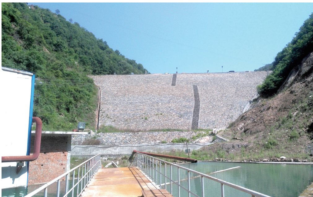
洋县尾矿库初期坝一角
