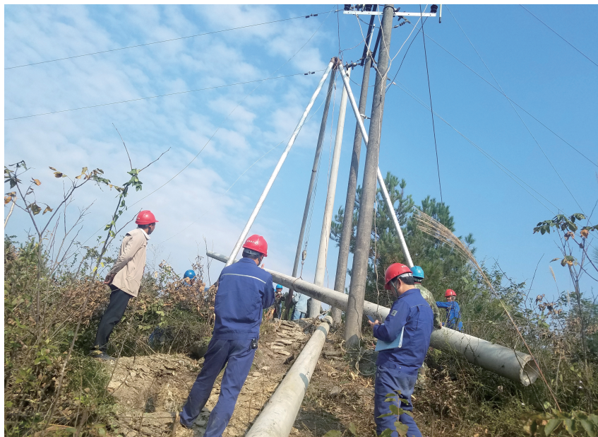
施工作业现场安全监督检查
